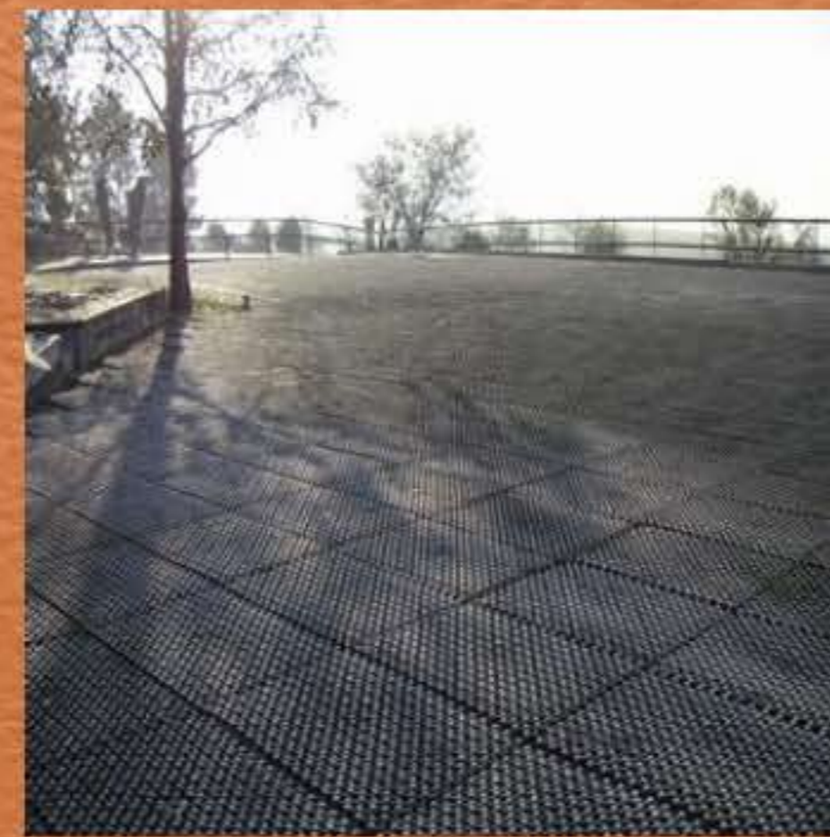
Trennschicht mit gelochten Reitmatten
